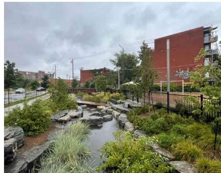
BASSIN DE BIORÉTENTION, PARC PIERRE-DANSEREAU Source : Ville de Montréal
